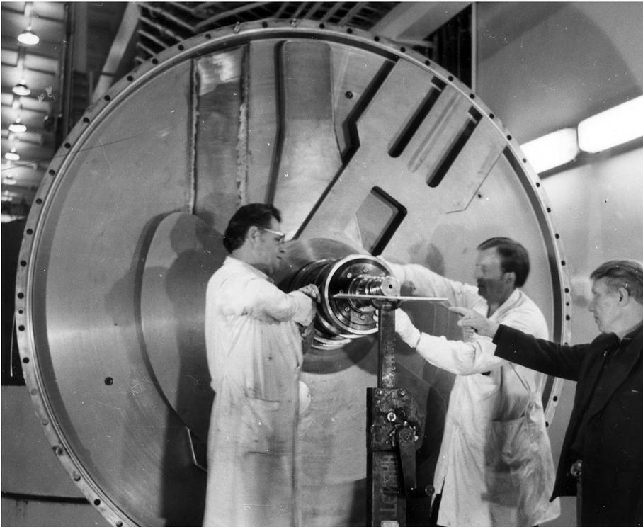
Сборка подвижного отражателя ИБР-2 на стенде
